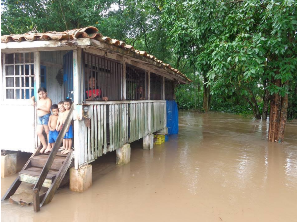
Fig. 25 – Inundação do Igarapé Santo Antônio em fevereiro de 2017 – Centro.
