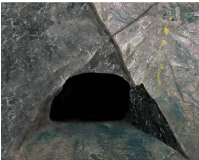
Figura 100 - Falhas importantes e intermediárias no Domínio Estrutural Balmaceda, mostrando a potencialidade de ocorrência de cunhas no teto da escavação, condicionadas pelos elementos estruturais (falhas, juntas e descontinuidades de forma geral).
