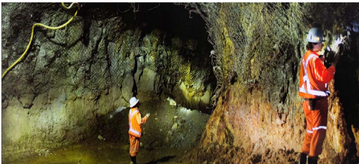
Figura 76 - Mapeamento dos parâmetros geológico-geotécnico da massa rochosa.
