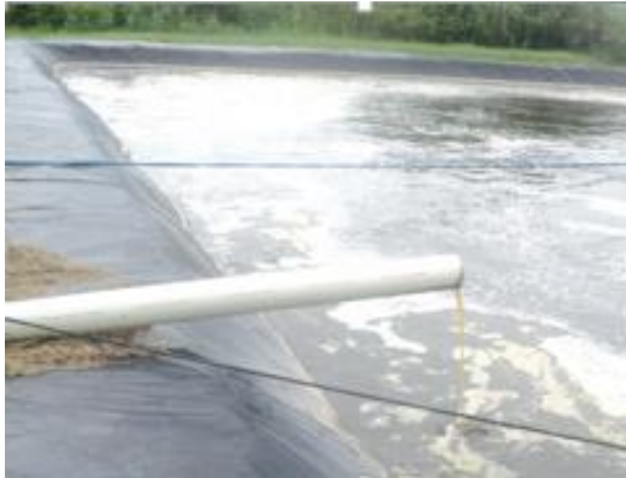
Figura 16 - Efluentes entrando na lagoa aeróbia
