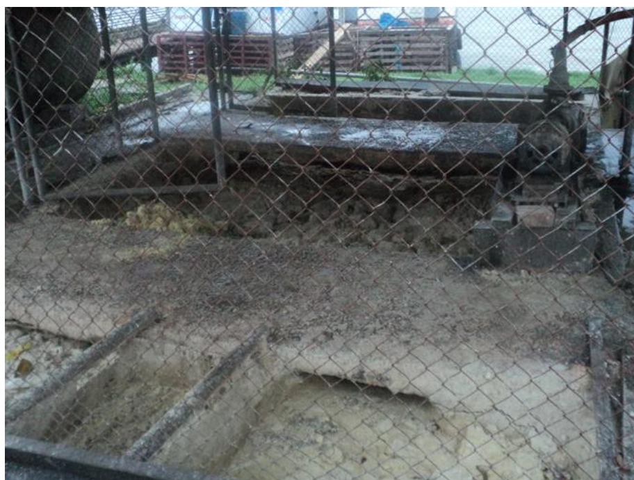
Figura 11 - Decantador de gordura ou sebo da Graxaria
