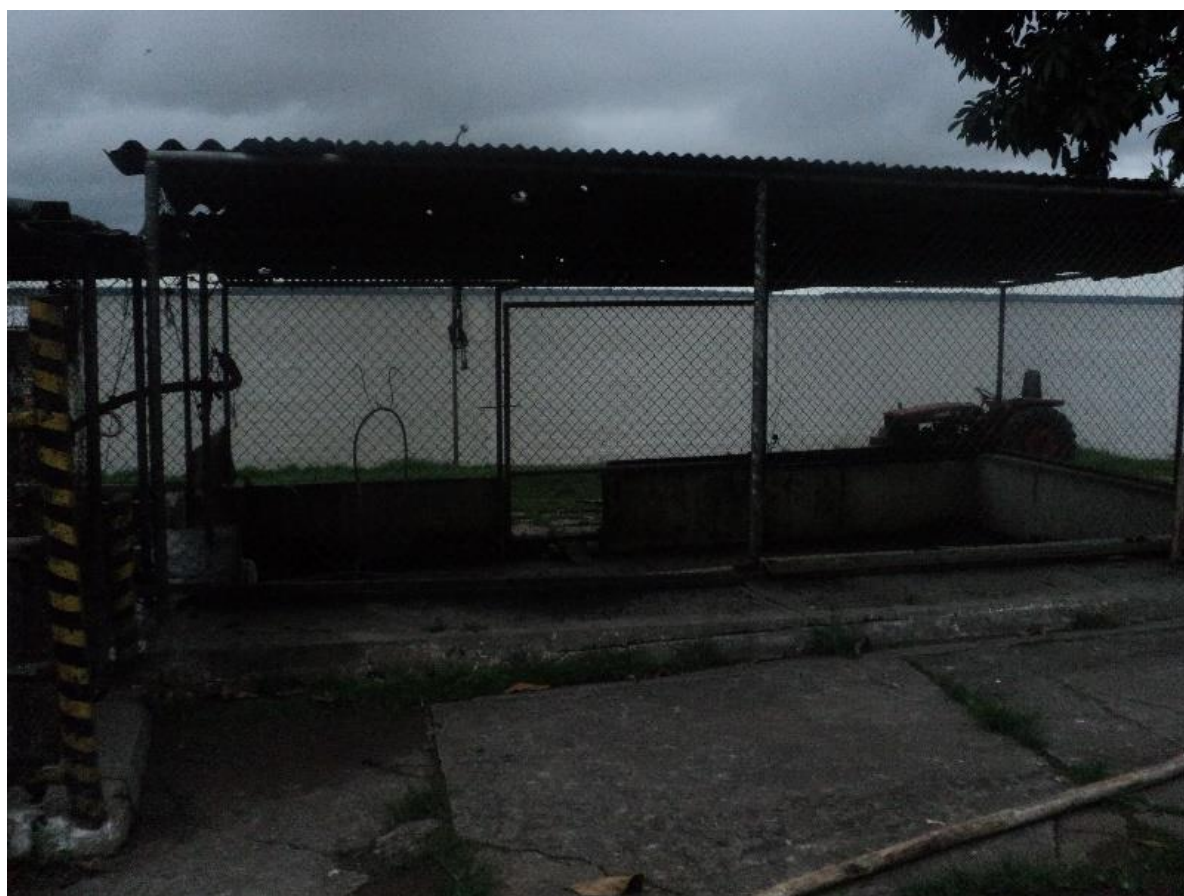
Figura 13 - Decantador de resíduos da Graxaria
