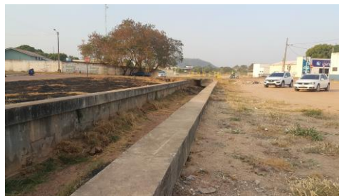
Figura 11. Trecho. Córrego Redenção. Obra de Canalização iniciada no ano de 2006, sem conclusão até a data atual. Trecho entre as Avenidas Inácio Oldoni e Ministro Oscar T. Filho. Fonte: O Autor
