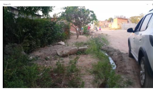
Figura 13 Trecho. Córrego do Gago. Lançamento de esgoto e águas residuárias ao longo do curso de água Fonte: O Autor
