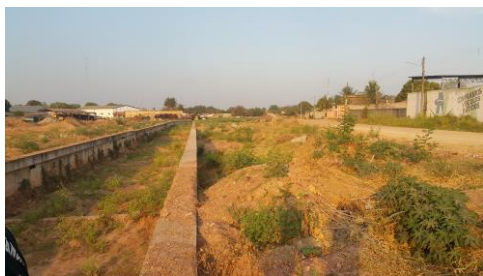
Figura 10 Trecho. Córrego Redenção. Obra de Canalização iniciada no ano de 2006, sem conclusão até a data atual. Trecho entre as Avenidas Inácio Oldoni e Ministro Oscar T. Filho. Fonte: O Autor
