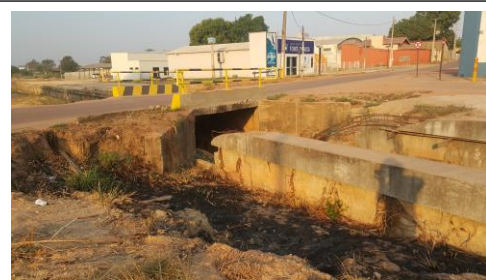
Figura 8 Trecho. Córrego Redenção. Obra de Canalização iniciada no ano de 2006, sem conclusão até a data atual. Trecho entre as Avenidas Inácio Oldoni e Ministro Oscar T. Filho Fonte: O Autor
