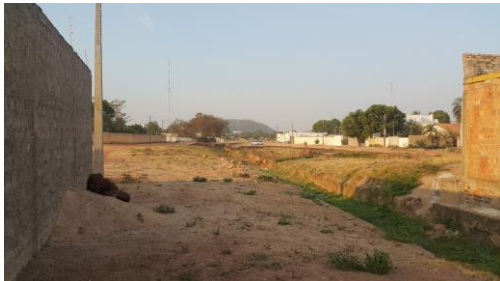
Figura 14 Trecho. Córrego Redenção. Retirada de toda a vegetação na faixa de preservação permanente. Fonte: O Autor
