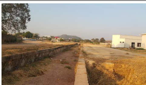
Figura 9 Trecho. Córrego Redenção. Obra de Canalização iniciada no ano de 2006, sem conclusão até a data atual. Trecho entre as Avenidas Inácio Oldoni e Ministro Oscar T. Filho Fonte: O Autor
