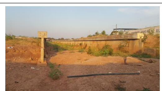
Figura 6 Trecho. Córrego Redenção. Característica dos solos encontrados no trecho estudado. Fonte: O Autor
