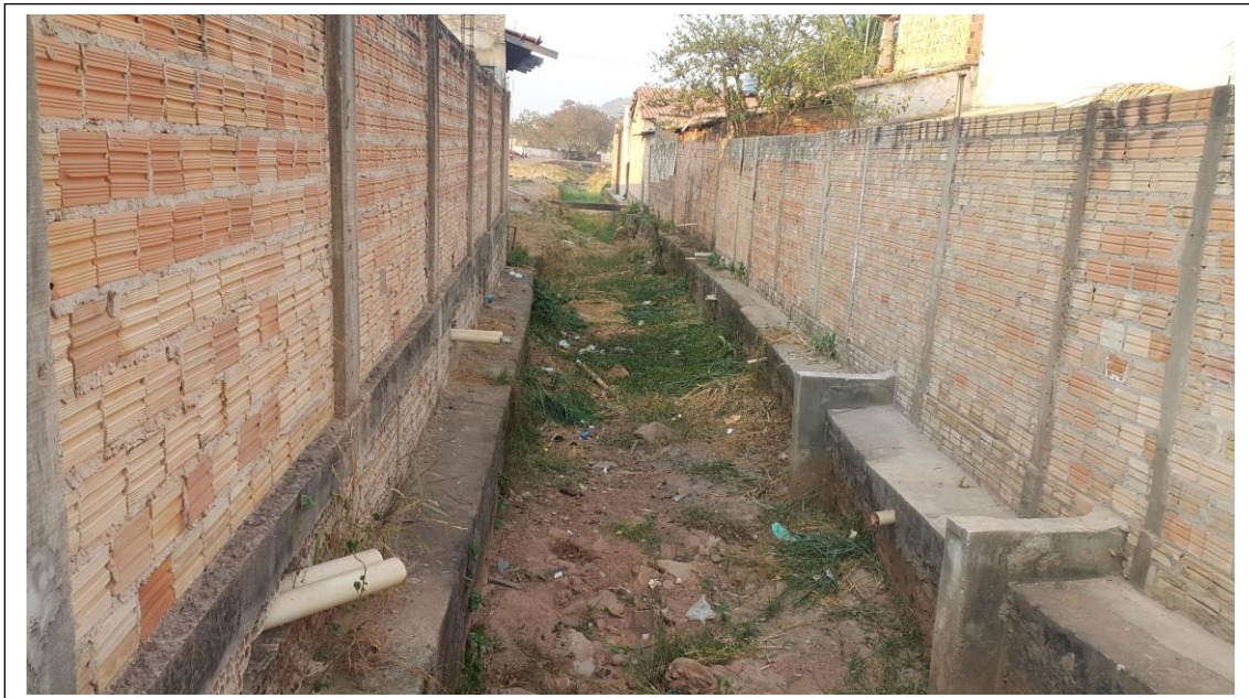
Figura 18 Paredes e muros das residências funcionando como arrimo contra enchentes. Foto: O autor
