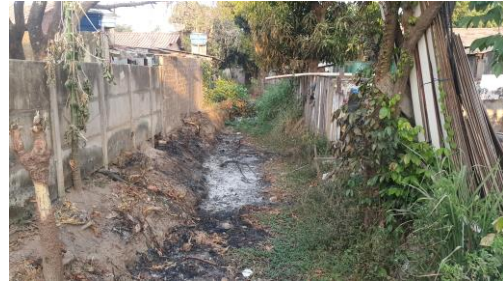
Figura 15 Trecho. Córrego do Gago. Retirada da vegetação para implantação de assentamento urbano. Fonte: O Autor
