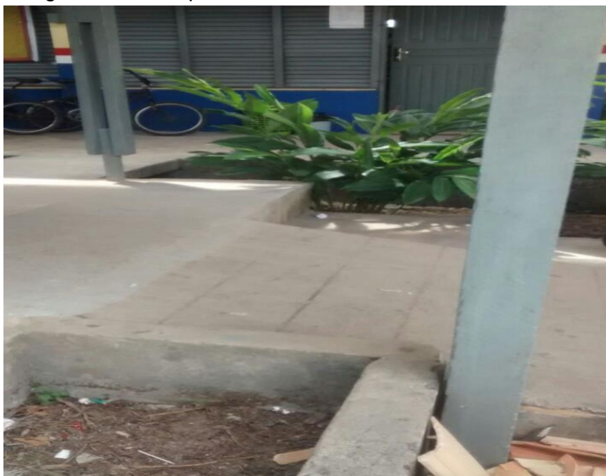
Fotografia 3 – Rampa de acesso na entrada da escola
