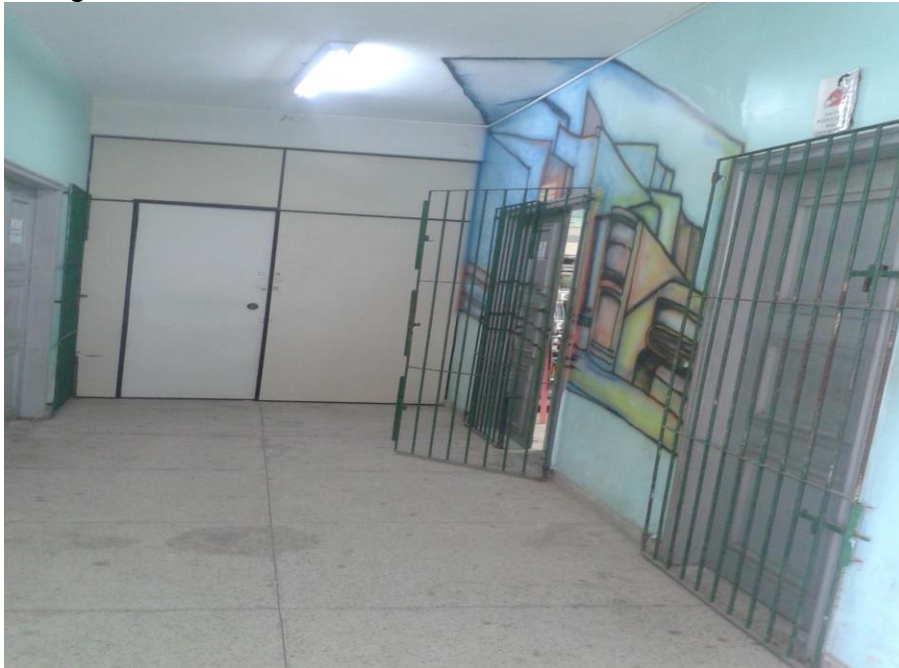
Fotografia 2: Corredor de acesso à biblioteca
