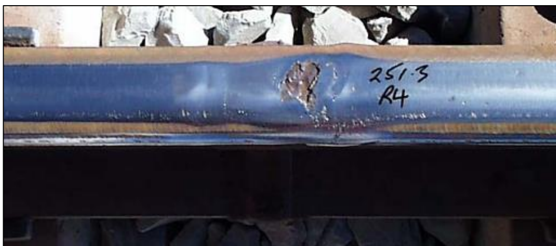
Figura 20 - Demonstração do defeito de canoamento em trilhos ferroviários.
