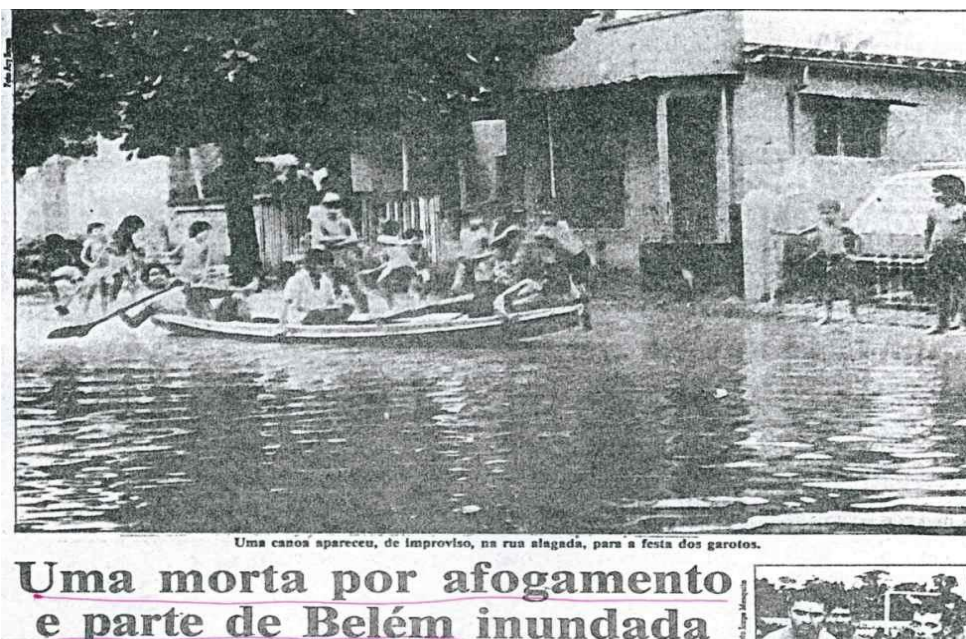
Figura 13 – Alagamento que causou morte na cidade de Belém-PA. Fonte: O Liberal.
