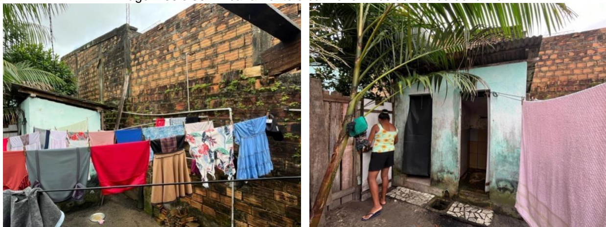
Imagem 35 e 36: Encanamento e banheiro - Residência da dona Marli.
