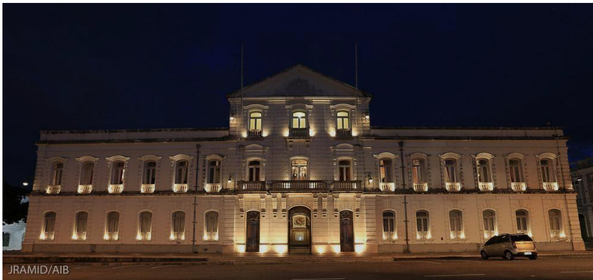
Figura 16 - Palácio Lauro Sodré, atual Museu Histórico do Estado do Pará.
