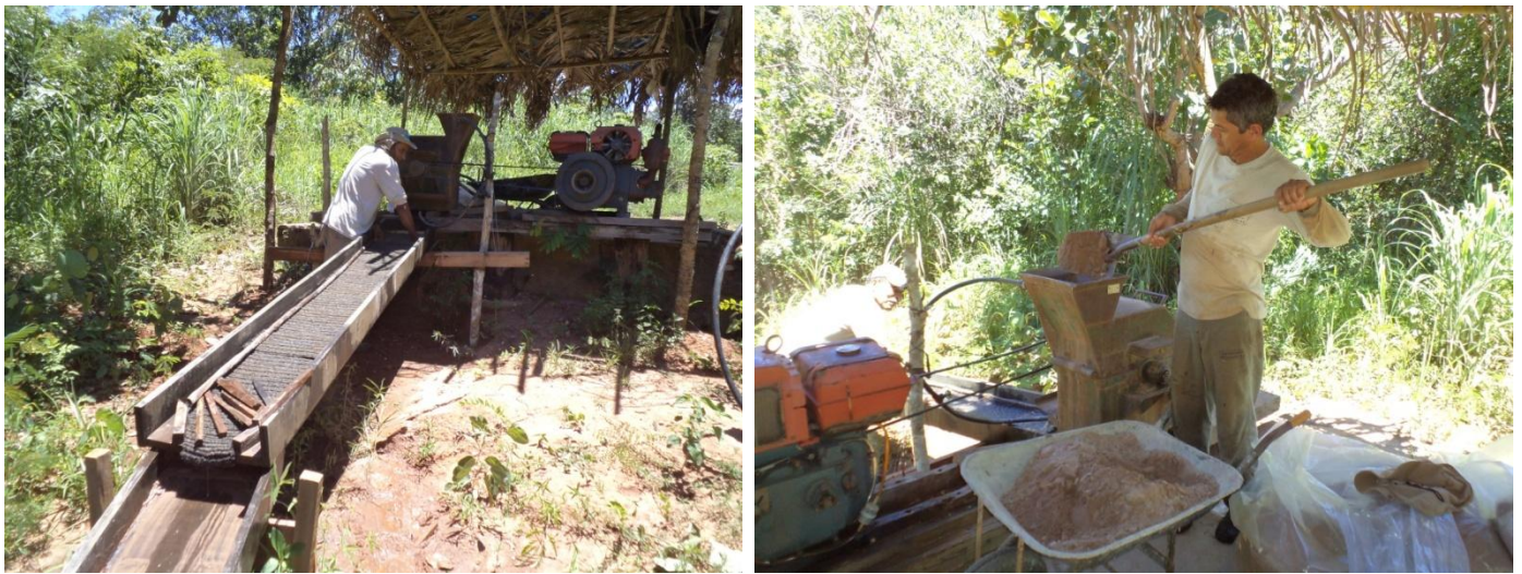
Fotos 08 e 09: Sistema de lavagem do material, visando a acumulação dos concentrados de minerais pesados presos nas esteiras.
