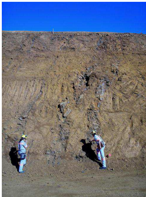
Figura 9 - Foto de talude de ISML com veios de sílexito em mapeamento geológico de detalhe 1:500.
