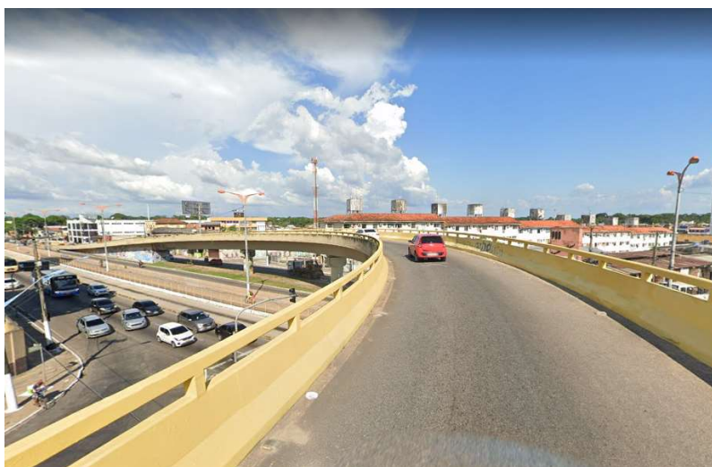
Figura 4 - Complexo viário que interliga as avenidas Doutor Freitas e Almirante Barroso, sem qualquer infraestrutura cicloviária, em Belém/PA.
