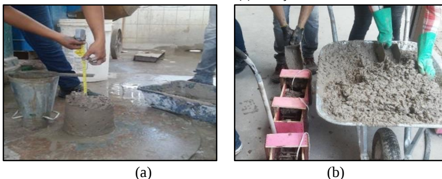
Figura 29 – Ensaio de abatimento do tronco de cone (a) e lançamento e adensamento do concreto (b).
