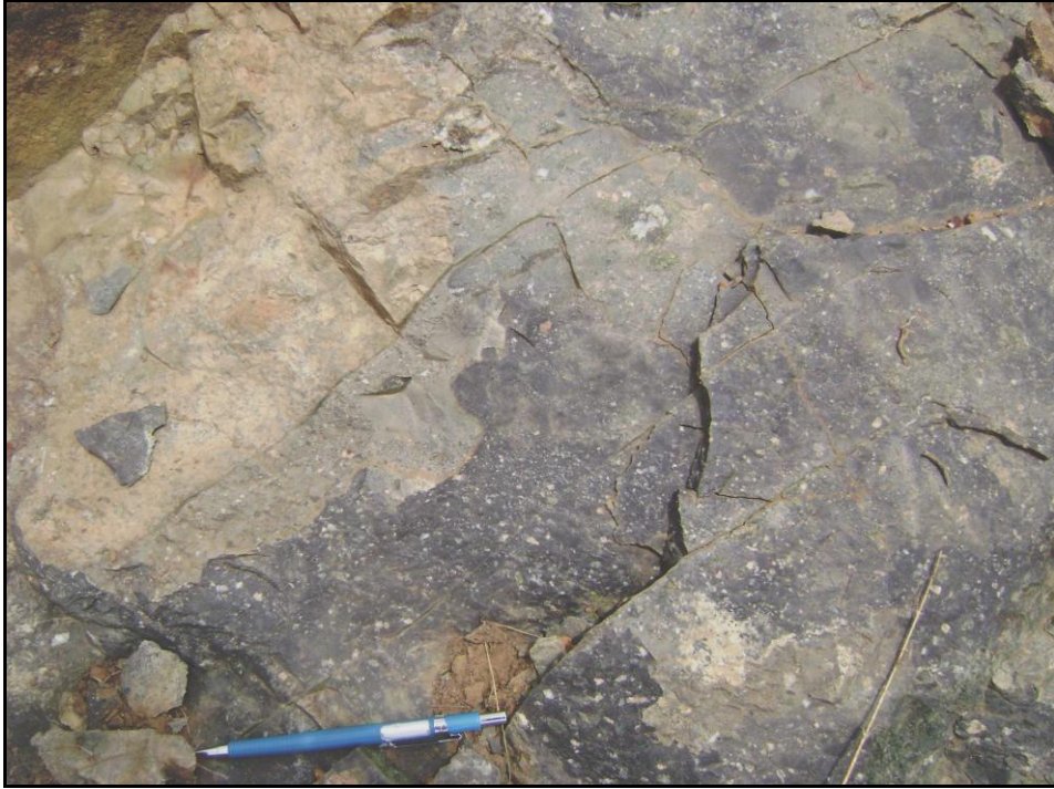
Figura 7 – Presença de intenso fraturamento nos arenitos, definindo um conjunto de famílias de juntas e fraturas paralelas e outras fraturas menores e perpendiculares (2008-TEC-01).
